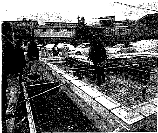
現在の住宅に求められる性能を持った基礎を工期短縮、コスト削減のうえで施工できる
